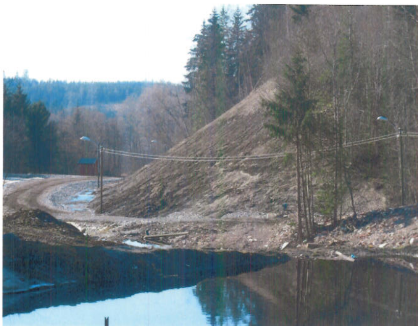
Figur 6 Foto av nedre leirskjæring ned mot nedre sivevannsdam. Avskjærende overvannsgrøft er synlig ved foten av skjæringen.
