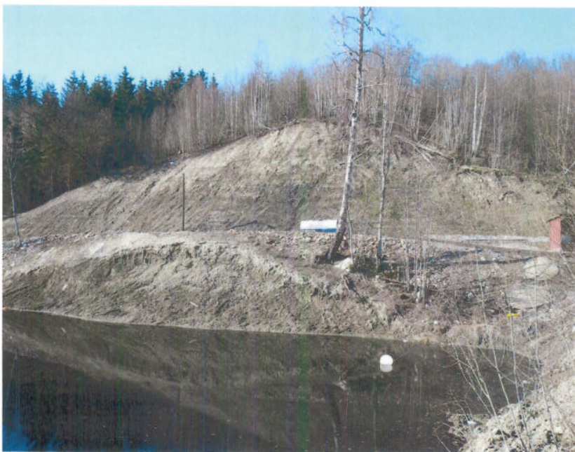
Figur 5 Foto av øvre leirskjæring med sedimentasjons basseng for overvann.
