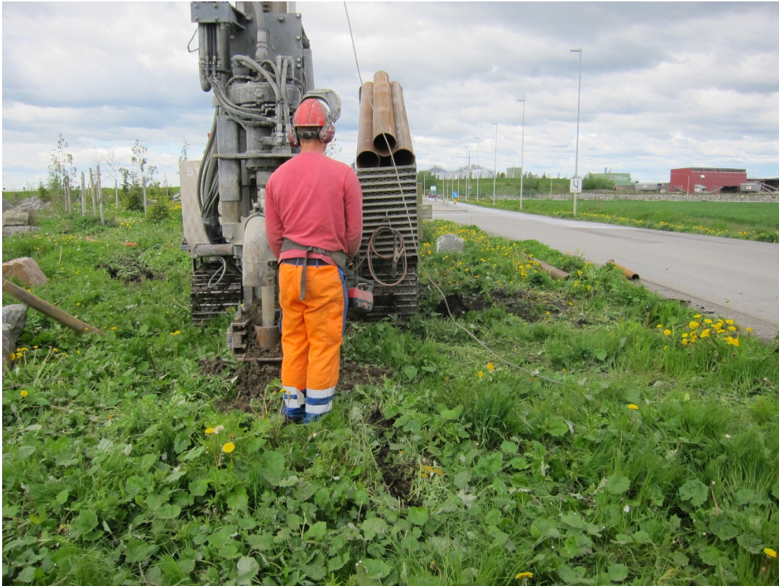
Figur 3 Installasjon av overvåkningsbrønnen Ob-1
